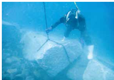
海底の岩などを取り除く際には人が直接潜って作業する場合もある。
