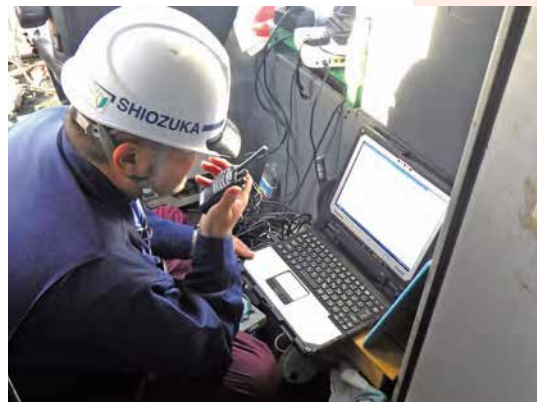
安全で確実に速やかに工事を進めるため、高い技術力を持ったオペレーターが連携して海上の重機を操作する。豊富な知識が必要となる作業。
