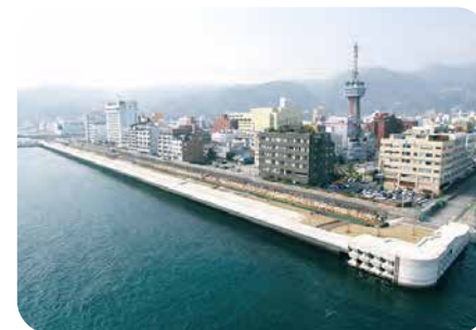
こうわん 港湾工事
