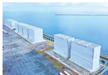
海に入れられる前の、防波堤の基礎となる部分『ケーソン』の製作も行う。
