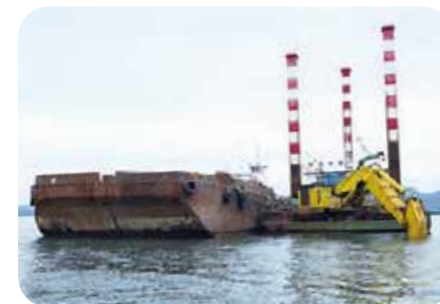
しゅんせつ 浚渫工事
