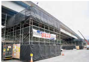
現場での事故を起こさないことが最も重要。常日頃から細心の注意を払う。
